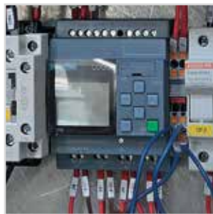
PLC pour la programmation des temps et des modes de nettoyage automatique.
