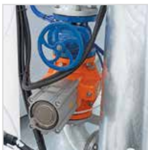
Évacuation automatique des boues du décanteur par une valve manuelle de fermeture de sécurité.
