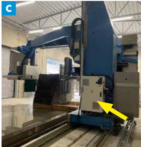
EN Technical area FR Zone technique DE Technischer Bereich ES Área técnica
